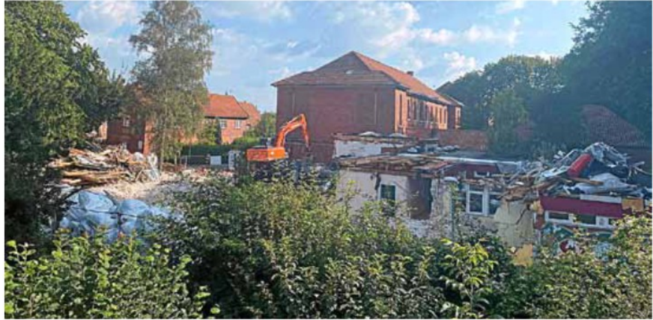
Ein Bagger hat das Kita-Gebäude am Fuße des Lüneburger Kalkbergs abgerissen, hier entsteht der Neubau. Foto: privat
